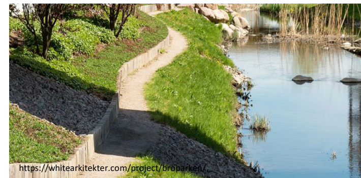
Lepolan hulevesikosteikko http://www.tuusulanjarvi.org/galleria/
